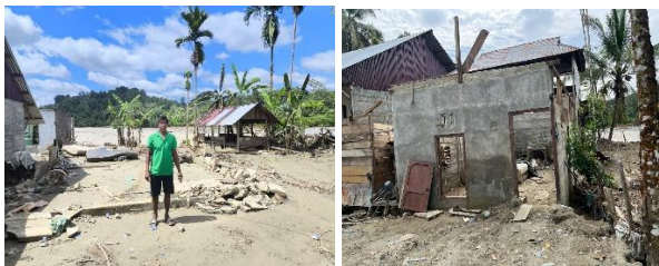
Gambar 2. Kondisi Rumah Warga
