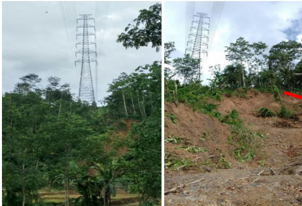
Gambar 1. Lokasi kelongsoran di bawah tower SUTT Listrik.
