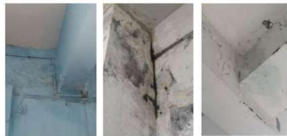
Gambar 16. Kondisi dinding Lantai 1 yang mengalami rembesan dan keretakan
