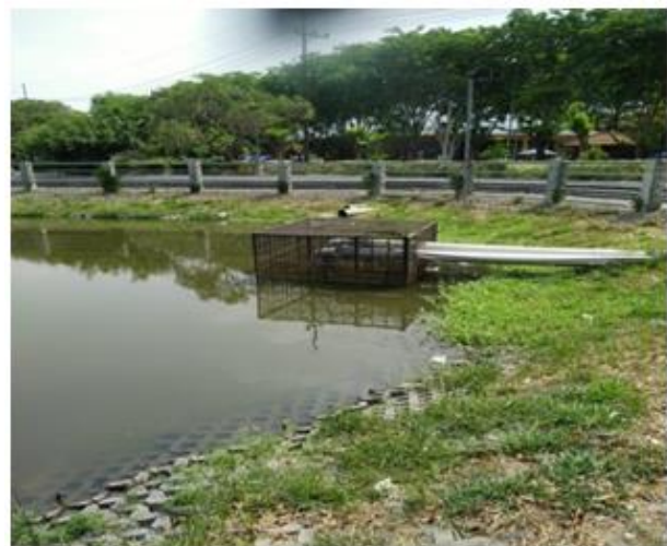
Gambar 3. Kondisi bangunan bozem di Unesa Ketintang
