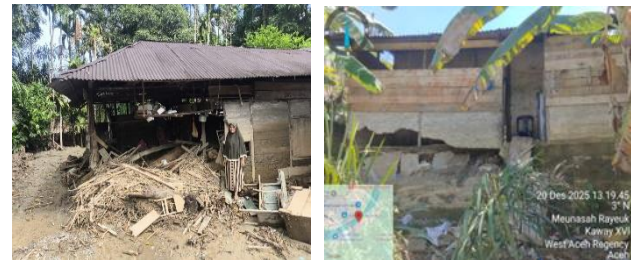
Gambar 4. Kondisi Struktur Dinding
