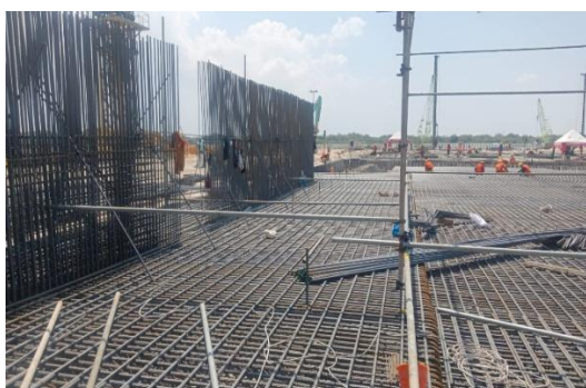
Gambar 2. Kondisi Lokasi Proyek
