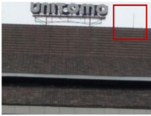
Gambar 23. Penangkal Petir
