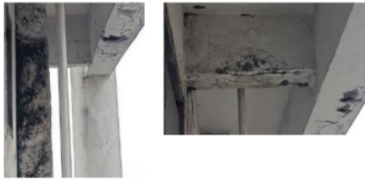
Gambar 13. Kondisi Balok Lantai 4
