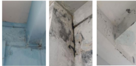
Gambar 11. Kondisi Balok Lantai 2
