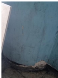
Gambar 10. Kondisi Kolom Bangunan Lantai 2
