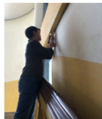
Gambar 21. Dokumentasi Hammer Tes pada Balok
