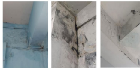
Gambar 15. Kondisi dinding Lantai 1 yang mengalami rembesan dan keretakan
