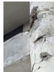
Gambar 12. Kondisi Balok Lantai 3
