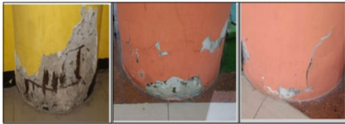
Gambar 9. Kondisi Kolom Bangunan Lantai 1
