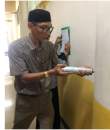
Gambar 22. Dokumentasi Hammer Tes pada Kolom
