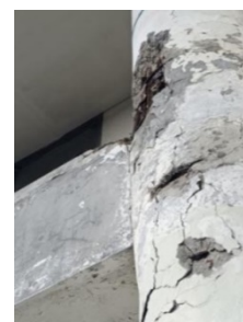
Gambar 12. Kondisi Balok Lantai 3
