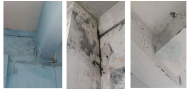
Gambar 11. Kondisi Balok Lantai 2
