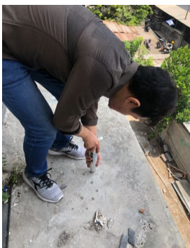
Gambar 20. Dokumentasi Hammer Tes pada Plat
