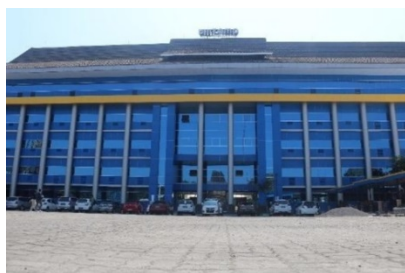
Gambar 8. Jalan Masuk Menuju Bangunan Gedung F
