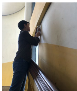
Gambar 21. Dokumentasi Hammer Tes pada Balok
