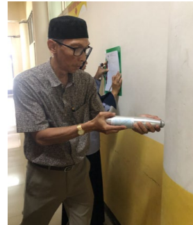
Gambar 22. Dokumentasi Hammer Tes pada Kolom
