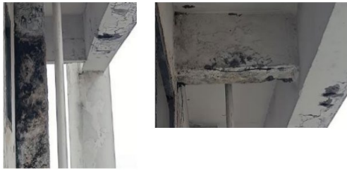
Gambar 13. Kondisi Balok Lantai 4
