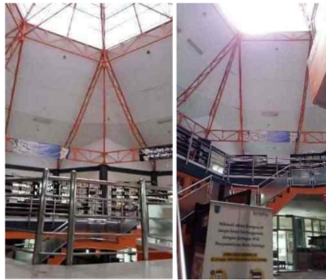
Gambar 5. Bukaan atap transparan Persipda Salatiga. sumber : Dok. Penulis 2022
