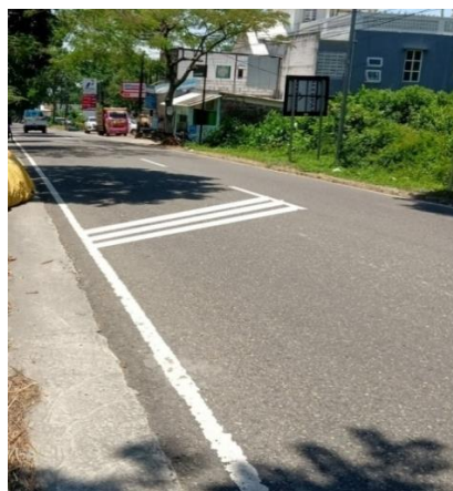
Gambar 11. Rekomendasi Penambahan pita pengaduh di Jalan Raya Plaosan. (Sumber: Analisis Penulis, 2023)
