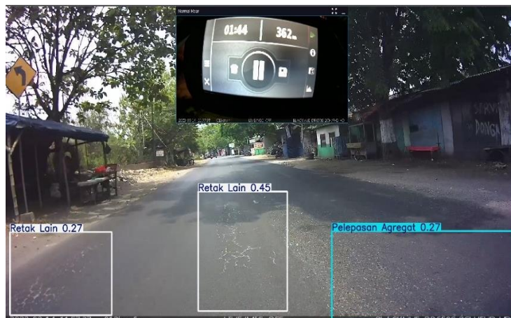
Gambar 5 Kerusakan pada STA 2+300 – 2+400 (Sumber: BlackVue dan Prototype Penulis, diakses bulan Maret 2024)
