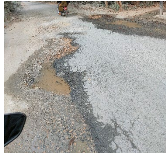
Gambar 11 Retak Pinggir
