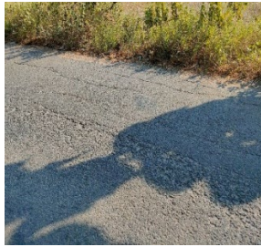
Gambar 7 Retak Memanjang
