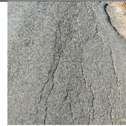
Gambar 9 Retak Berkelok-Kelok
