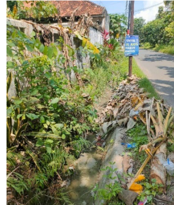
Gambar 23 Drainase di Jl. Raya Labang
