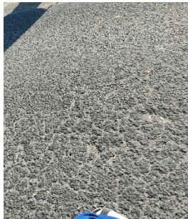
Gambar 10 Retak Kulit Buaya
