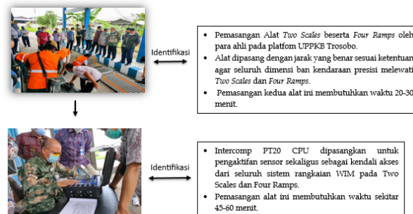
Gambar 6. Pemasangan Two Scales dan Four Ramps serta pemasangan dan pemrograman PT20 CPU
