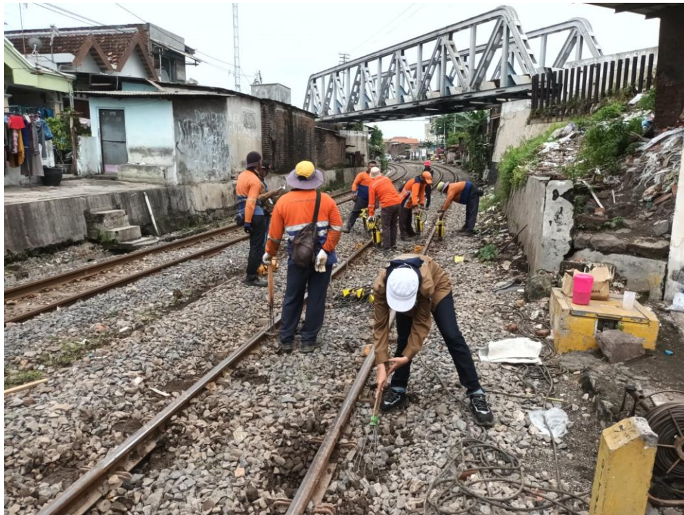
Gambar 3. Proses Pekerjaan Lestrengan
