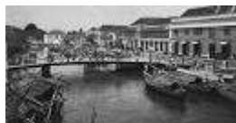
Gambar 2. Pembangunan Irigasi dan Jembatan Beton Way Balau di Teluk Betung
