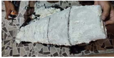
Gbr 10 Penyemprotan PU Spray Foam
