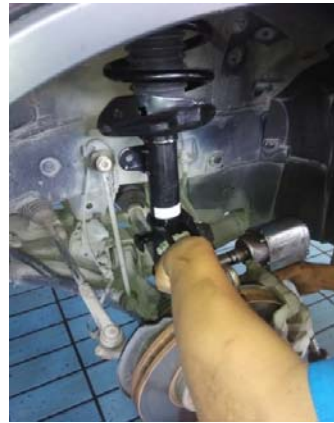
Gambar 21. Pemasangan Shock absorber
