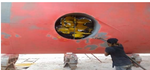
Gbr 11. Proses blasting pada area-area yang harus diciptakan profil baru untuk pengecatan ulang
