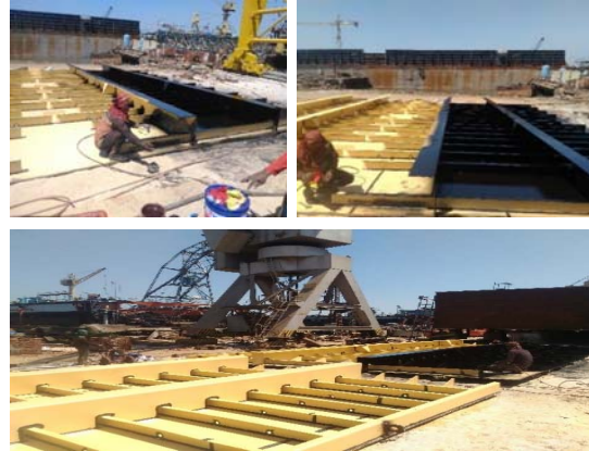
Gbr 15. Proses pengecatan menggunakan airless spray pada tutup ponton.
