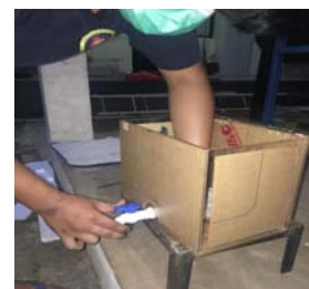
Gbr. 14 Pemasangan Keran pada Tanki Air Tawar
