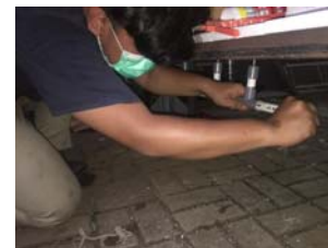
Gbr 13. Pemasangan Pipa PVC ke Arah Tanki Air Tawar
