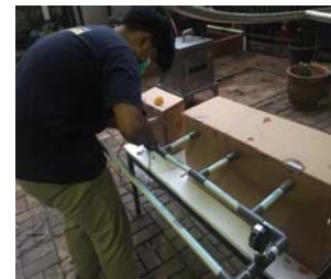
Gbr 12. Pemasangan Pipa ke Pompa Air Laut
