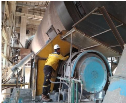
Gambar 7. Proses pengecekan temperatur bearing pada supporting roll .
