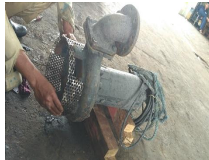
Gambar 7 Proses improvisasi pemasangan jaring besi di dinding intake Submersible Pump
