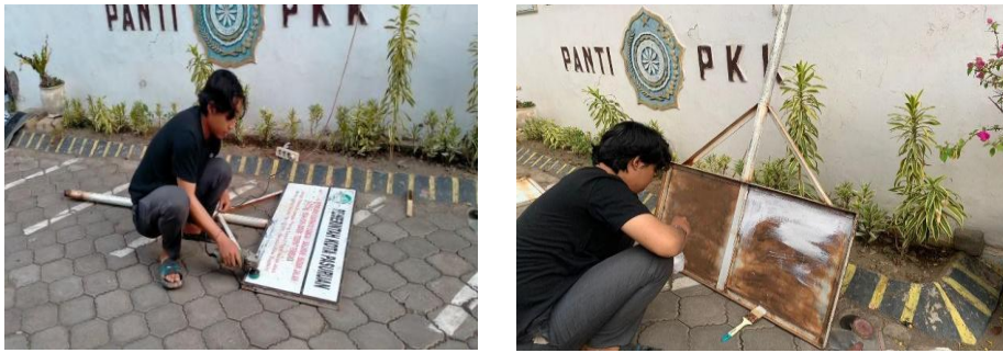
Gambar 3. Pengamplasan dan Pengecatan Plang Peringatan
