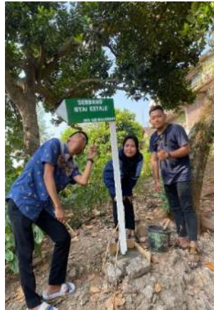
Gambar 3 Pemasangan Plang menuju Sendang
