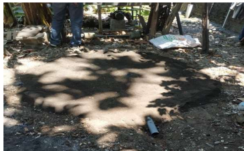
Gambar 5. Kegiatan Perataan tanah dan Pemasangan Pipa Pembuangan Air
