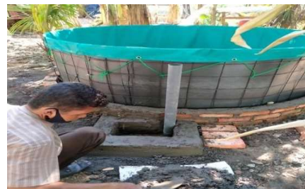
Gambar 6. Kegiatan Perataan tanah dan Pemasangan Pipa Pembuangan Air
