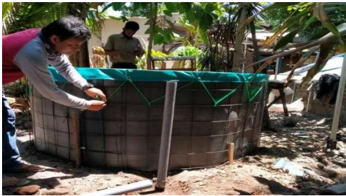
Gambar 7. Kegiatan Pemasangan Batu Bata dan Pembuatan Bak Kontrol
