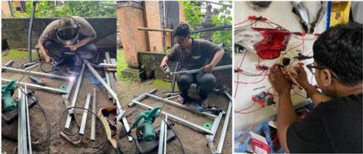
Gambar 3. Dokumentasi Fabrikasi Rangka dan Instalasi Komponen Kelistrikan
